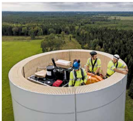
Sägeroboter haben die 16 bis 24 Meter langen Holzmodule zurechtgeschnitten. An ihnen wird eine 2-Megawatt-Windturbine befestigt, die etwa 500 schwedische Haushalte mit Strom versorgen kann.
